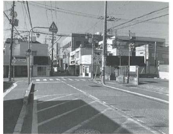
▲部分的に道幅が広がっている桜井駅前の道路
