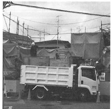
▲1週間弱で解体された住宅
