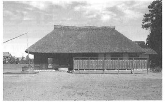
▲栃木県真岡市にある桜町陣屋跡
