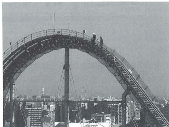
▲後樂園遊園地のジェット・コースターを点検する作業員
